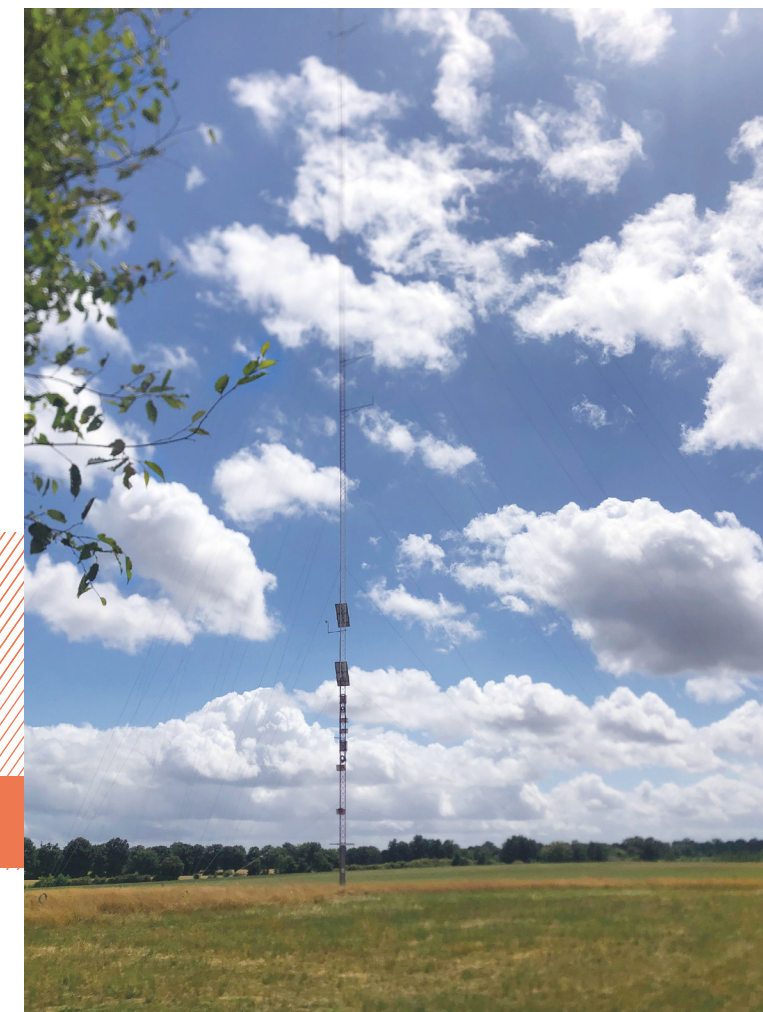
Mât de mesures installé sur la commune de Val d'Issoire.
